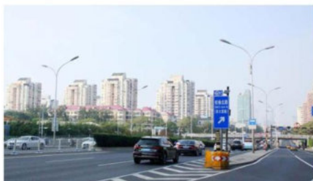
北京市东三环路灯改造工程
