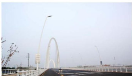
北京首钢大桥照明工程
