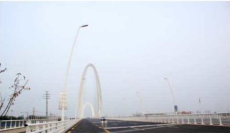
北京首钢大桥照明工程
