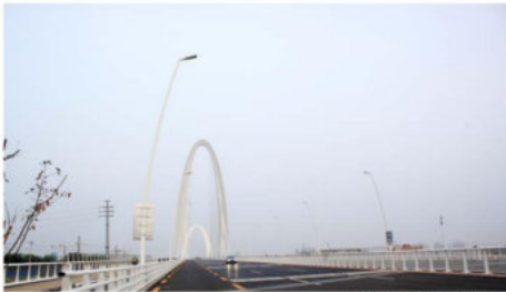
北京首钢大桥照明工程
