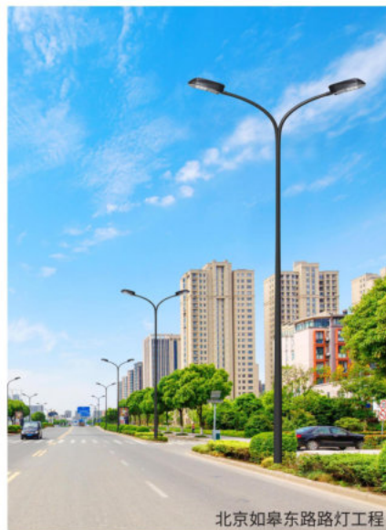
北京如皋东路路灯工程
