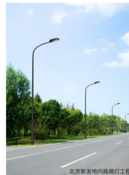
北京新发地内路路灯工程
