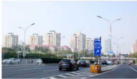
北京市东三环路灯改造工程
