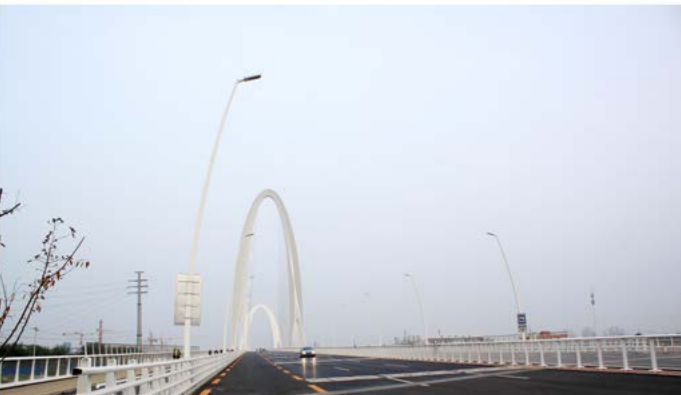
北京首钢大桥照明工程
