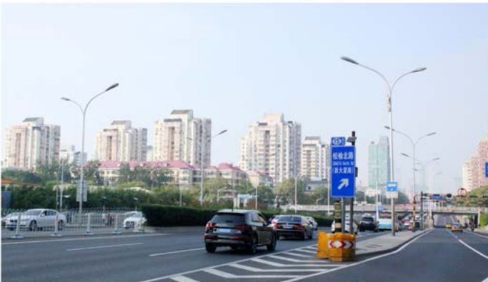
北京市东三环路灯改造工程
